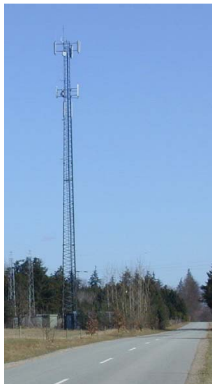
Figur 37 Senderen i Vorbasse. Antennen er en 2-stakket dipol på toppen af masten
