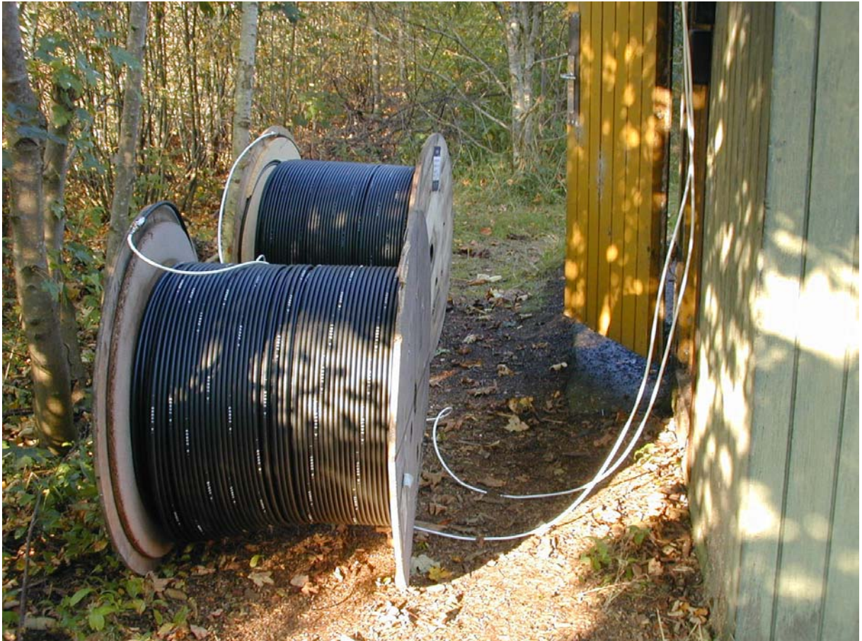
Figur 66 1 km antennekabel til indførelse af tidsforsinkelse på 3.75 \mu s Kabel er venligst udlånt af Borch Teknik, som også har stået for levering og afhentning i Sønder Omme.
