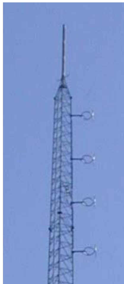
Figur 51 4 Cirkulære dipol-antennener i Sønder Omme
