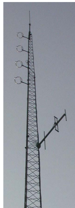
Figur 25 Masten i Viby, med de 4 cirkulære antenner og ballempfang-antennen nederst.
